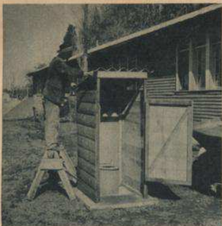
La construcción y colocación adecuada de letrinas sanitarias contribuyen notablemente a impedir la contaminación de las aguas y a mejorar las condiciones de salubridad. Un obrero pone los últimos toques a una letrina sanitaria en los talleres del programa de Higiene Rural del Plan Chillán.
