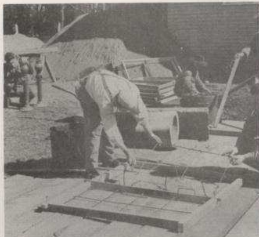
Visto parcial de los Talleres Sanitarios
