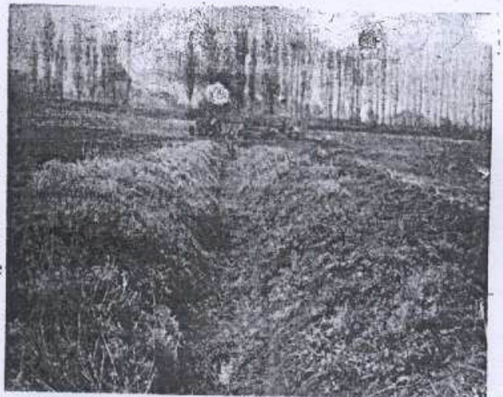
Desagüe recién trazado con una niveladora. La persona del fondo muestra su amplitud.
