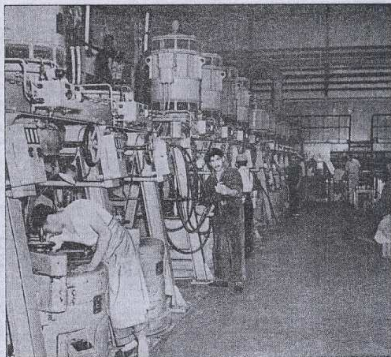
Aspecto interior de la planta de la Industria Azucarera Nacional, S. A., en Los Angeles.
