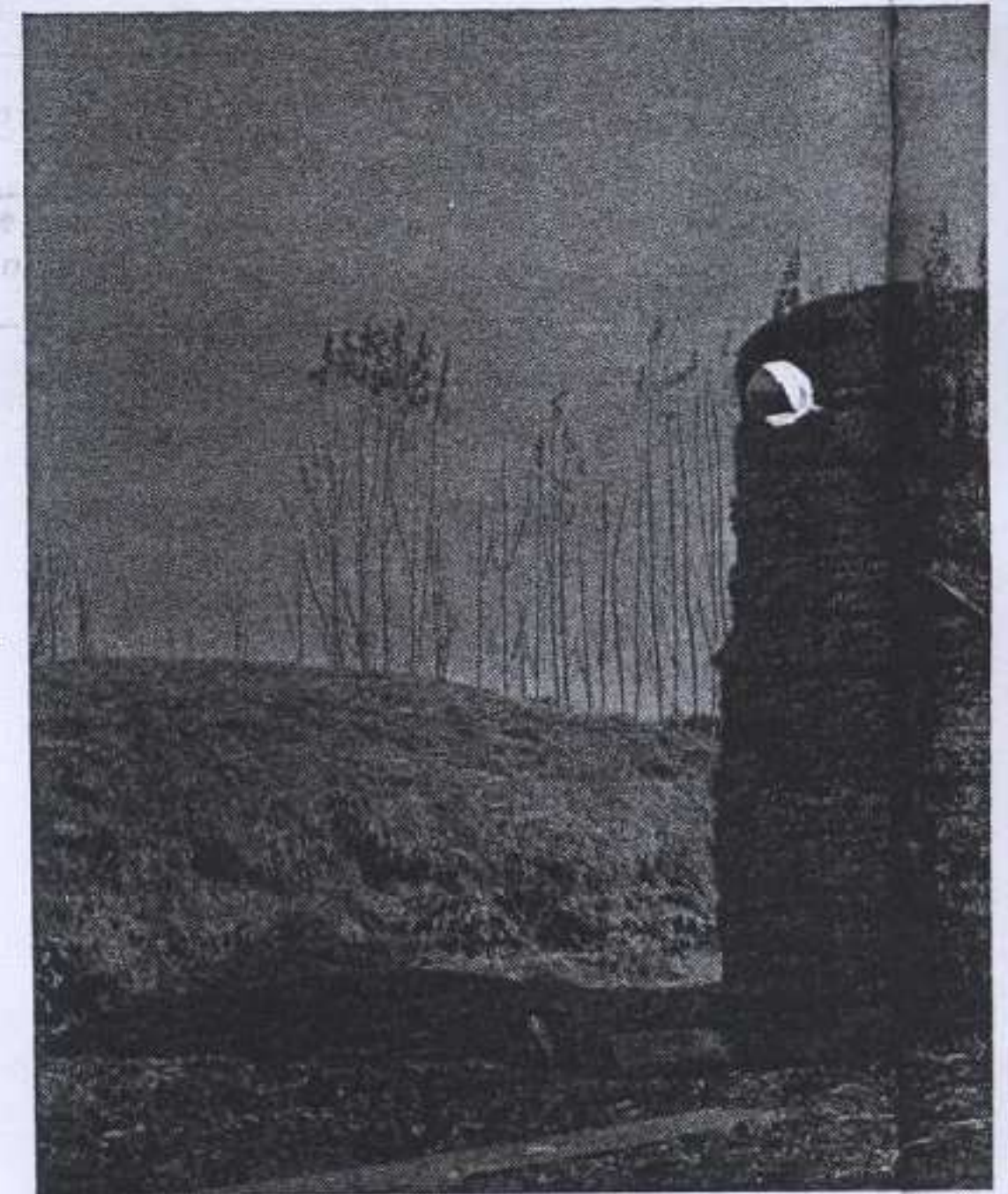
Silo rústico de torre, forrado con fardos de paja. Existen preservaci del i
