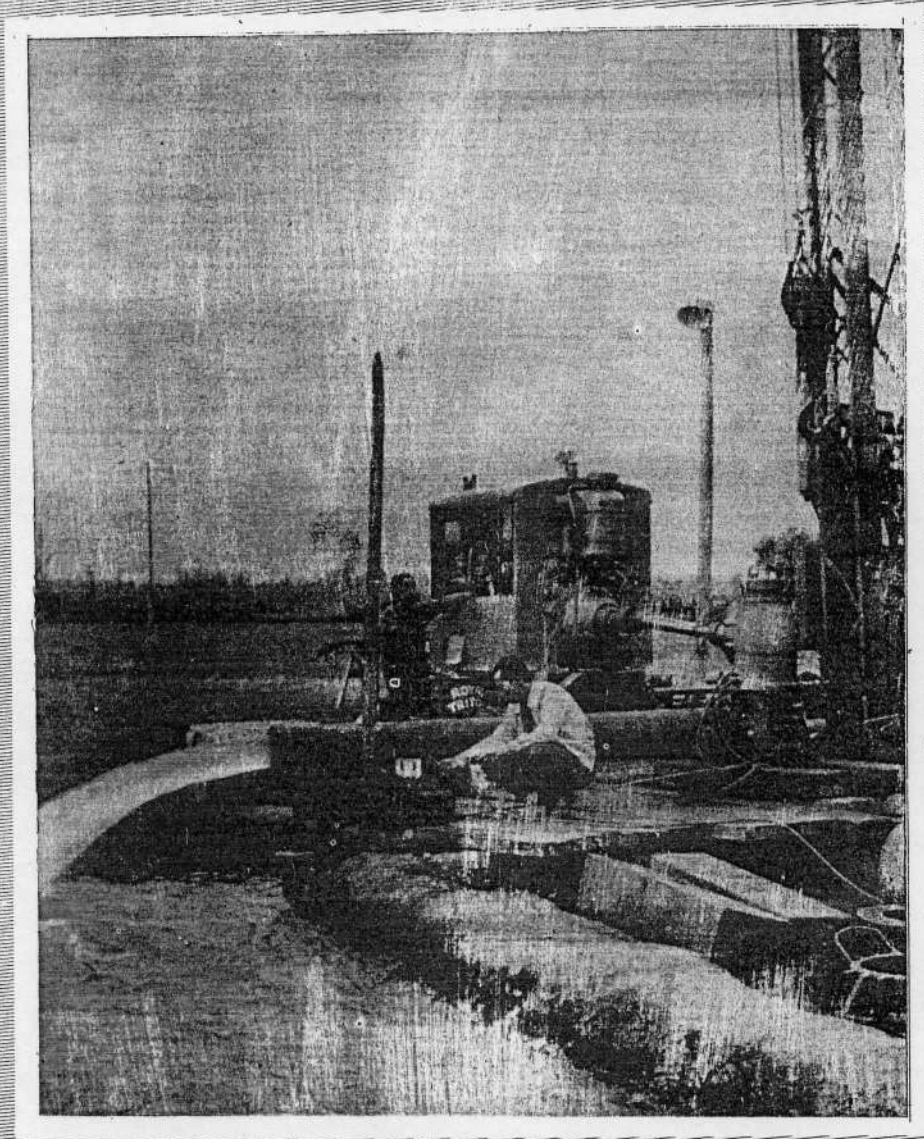
Prueba de agotamiento del Po zo N° 4.-
